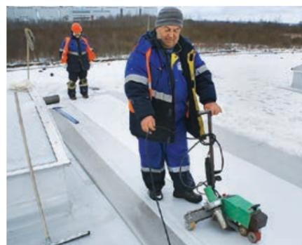
3. Осуществите приварку LOGICROOF NG полосами при помощи автоматического оборудования
