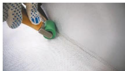
1. Раскатайте защитный материал LOGICROOF NG и приварите его к мембране вдоль стенки люка дымоудаления при помощи ручного фена
