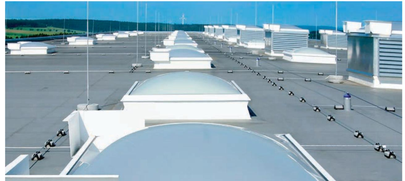
Согласно СП 7.13130.2013 «Отопление, вентиляция и кондиционирование. Требования пожарной безопасности», вокруг люков дымоудаления необходимо предусматривать противопожарные рассечки исключительно негорючими материалами на расстоянии не менее 2 м от края выбросного отверстия (от люка). Часто функции дымоудаления и вентиляции совмещены в зенитных фонарях с функциями освещения.
