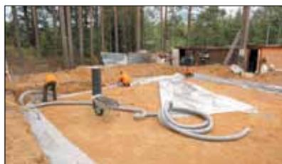
– Произвести монтаж закладных под ввод воды и произвести обустройство дренажной системы.
