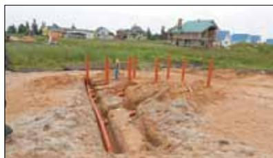
– На выровненном основании, согласно рабочей документации, разметить будущую систему канализации.
