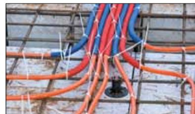
– При раскладке труб все места их пересечений с ребрами жесткости, на которых будут располагаться несущие перегородки или дверные проемы, необходимо защитить гильзами из специальной гофрозащиты или ПНД трубы длиной 400–500 мм.
