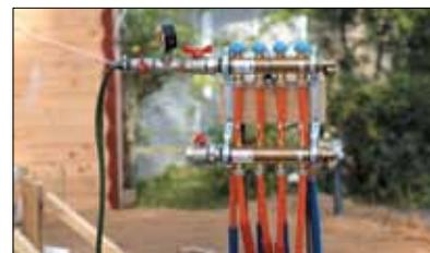
– Для монтажа коллекторов вбивают 2 или 4 стержня арматуры Ø12 мм, длиной около 1,5 м, к которым крепят на необходимой отметке доску под монтаж коллекторов. Места подъема труб к коллекторам также необходимо защитить специальной гофрозащитой.
