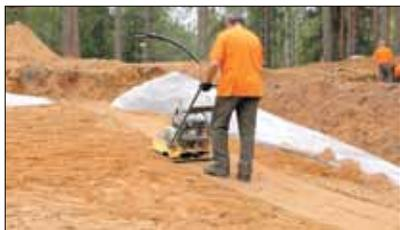
– Уплотнение песка производить виброплитами послойно с проливкой водой, толщина слоев должна быть не более 15 см.
