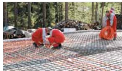
– По уложенной арматурной сетке произвести раскладку труб теплого пола в соответствии с рабочими чертежами. При раскладке труб для крепления к арматурной сетке используют нейлоновые хомуты.
