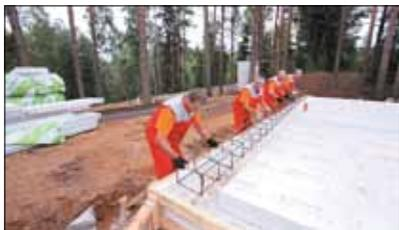
– По причине сложности производства работ на полистироле, рабочую арматуру следует связать в каркасы на земле в стороне от формы, а затем установить готовые каркасы в форму на фиксаторы и связать их.
