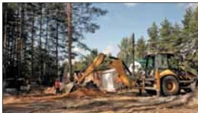
– При механической разработке котлована снимается только верхний плодородный слой (30–40 см). По возможности разработку котлована провести до материнского грунта.
