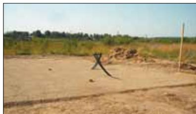
– Произвести проверку горизонтальности подготовленного основания и соответствие высотной отметки проекту и генеральному плану.
